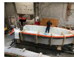
Fabrication de la coque (ajout de renforts de fibres de verre)
