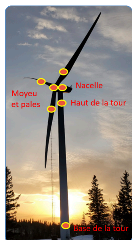
Figure 3. Stations de mesure installées dans WEC001
